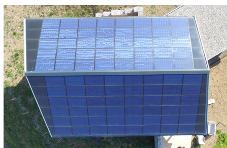
3 L'installation PV de 24 kW placée sur le toit génère 23'500 kWh/a.
